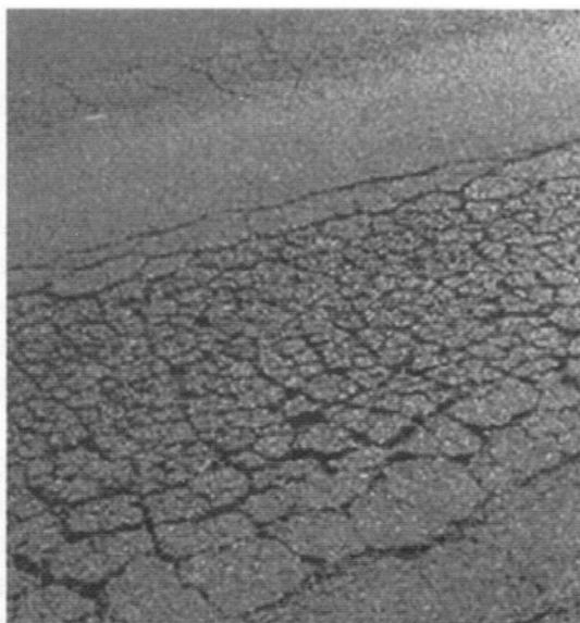
Figura 9. Deterioro generalizado en pavimento envejecido
