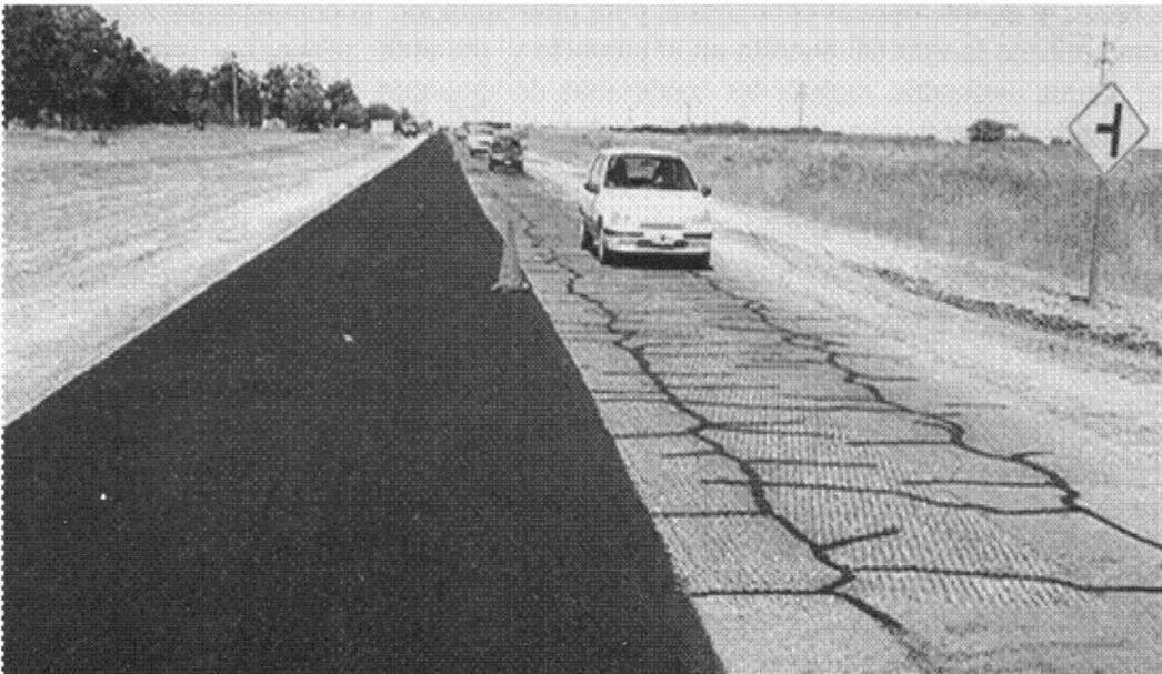
Figura 2. Trabajos de rehabilitación: fresado, sellado de fisuras y recapado con mezcla asfáltica
