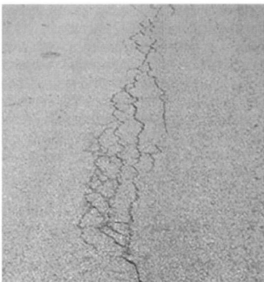
Figura 8. Fisuras por fatiga en pavimento envejecido
