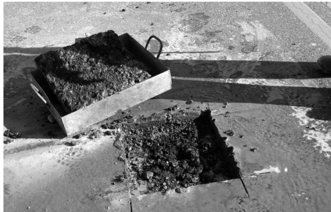
Figura 9. Extracción de muestra de pavimento en área exudada
