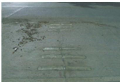
Imagen 10: Trabajo finalizado y aplicación de membrana de curado.
