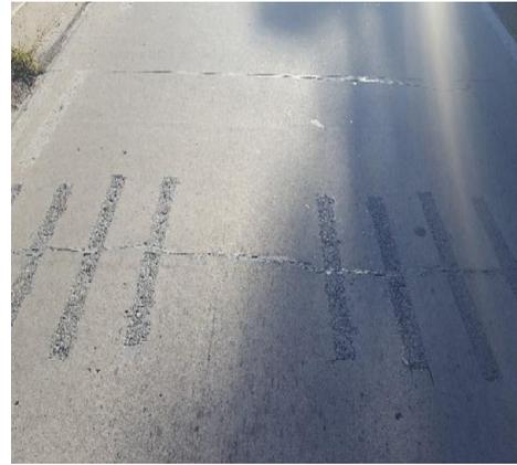
Imagen 17: Losa número 2, presenta desgaste prematuro de hormigón de DBR, probablemente por deficiencias de dosificación y/o curado.
