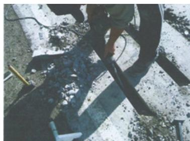
Imagen 6: Demolición y retiro hormigón de cavidades.
