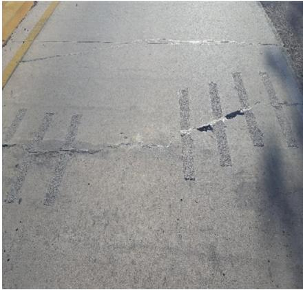
Imagen 16: Losa número 3, presenta desgranamiento de hormigón de junta pero buen comportamiento DBR.
